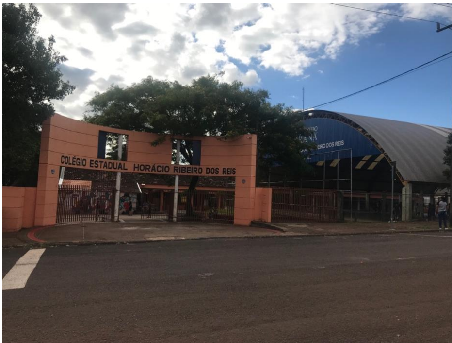
Figura 4: Entrada do colégio.
