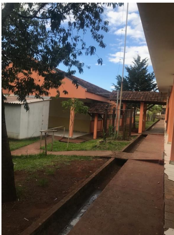
Figura 15: Rampa de acesso.
